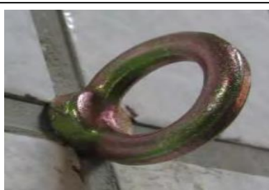
安裝膨脹螺絲+旋緊扣環
