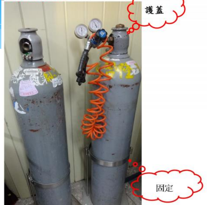
氣體鋼瓶固定加護蓋照片：
