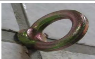
安裝膨脹螺絲+旋緊扣環
